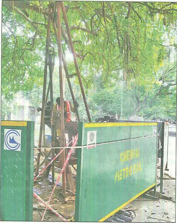
மாதவரம்-சிறுசேரி இடையே அமைக்கப்பட உள்ள மெட்ரோ ரெயில் திட்டத்துக்காக, அடையாறு இந்திரா நகர் பகுதியில் மண் சோதனை நடந்து வருவதை படத்தில் காணலாம்.
