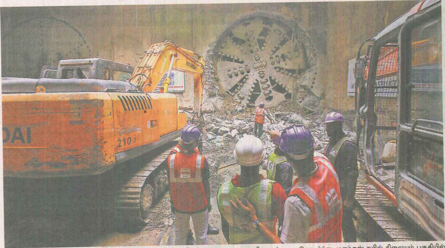
► மே தின பூங்கா- சைதாப்பேட்டை இடையே மெட்ரோ ரயில் சுரங்கப்பாதை பணி முடிந்ததை தொடர்ந்து, டிஎம்எஸ் ரயில் நிலையம் பகுதியில் டனல் போரிங் மிஷின் பாறைகளை உடைத்துக்கொண்டு வெளியே வருகிறது.
