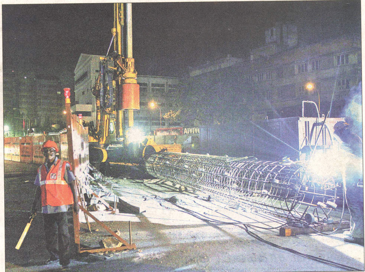
சைதாப்பேட்டை அருகே மெட்ரோ ரயிலுக்கான பீம் அமைக்க கம்பி கட்டும் பணி இரவுபகலாக நடந்து வருகிறது.
