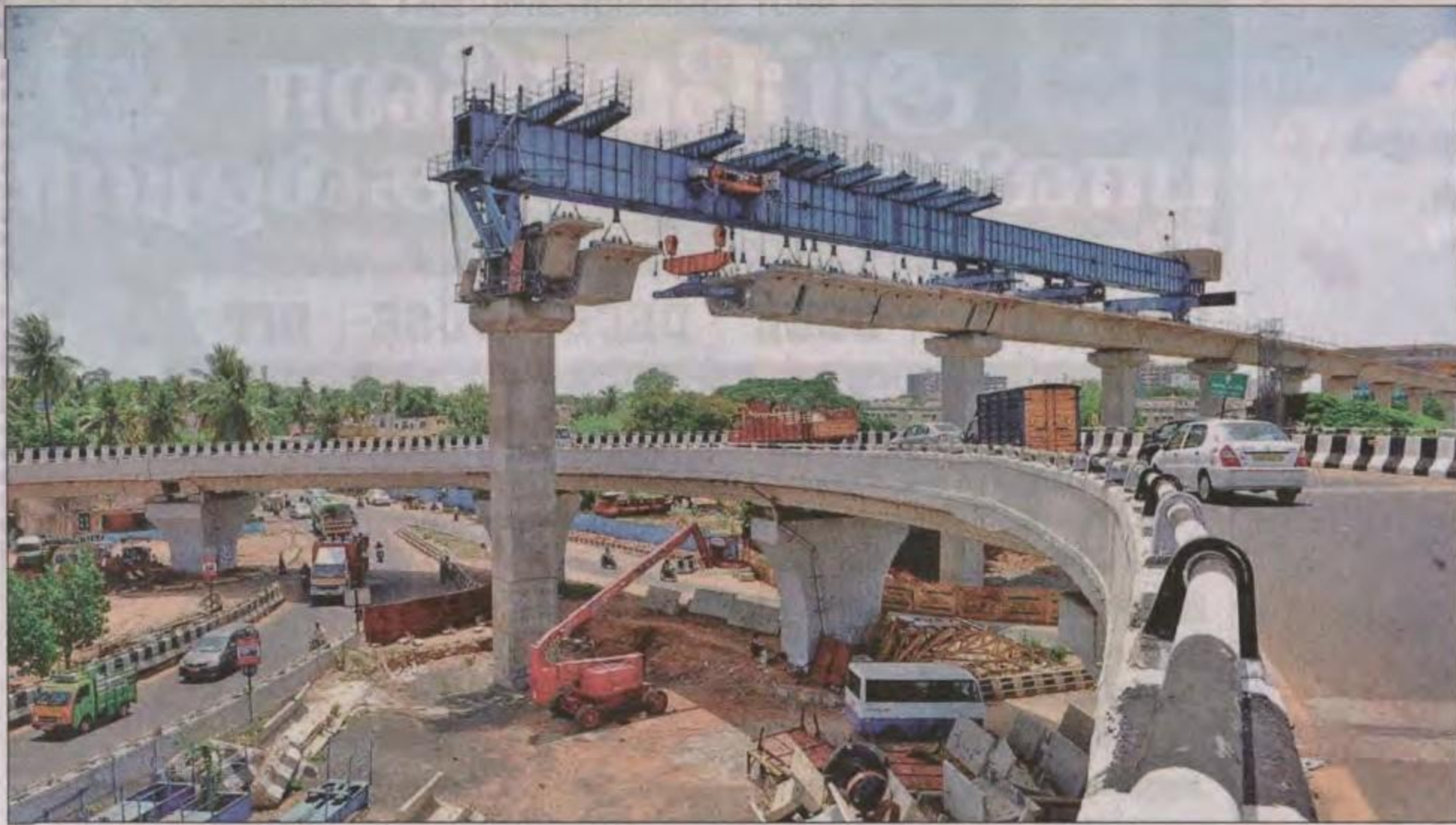
சென்னை கிண்டி மேம்பாலத்துக்கு மேலே மெட்ரோ பறக்கும் ரெயில் பாதை அமைக்கப்படுவது சிறப்பம்சம். தரையில் இருந்து பிரமாண்ட தூண்களுடன் 72 அடி உயரத்தில் இந்த பாதை கட்டப்படுவதை படத்தில் காணலாம்.
